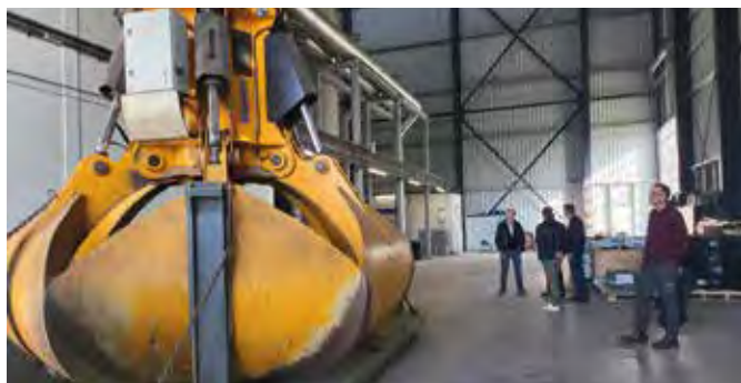
Maschinen der Heizungsanlage bei Emsflower
